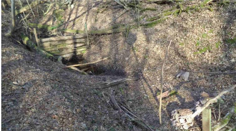
**Abbildung 18: Zugesetzter Geröllfang; 16.02.2017;
