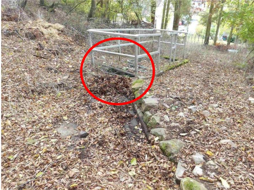
**Abbildung: Zulauf Geröllfang Oberhalb Haus 15 und 17, Blick in Fließrichtung**
